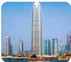
■ 上海金茂大厦 Shanghai Jinmao Tower
