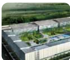
■ 农行数据中心 ABOC Data Centre
